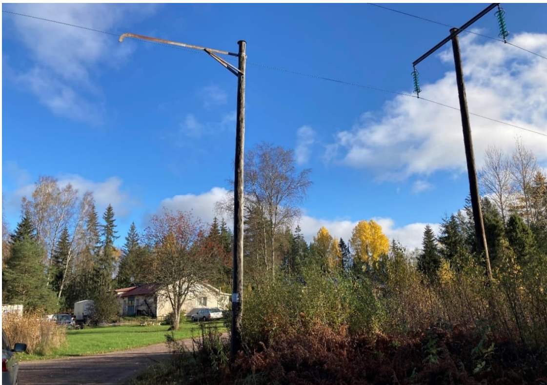
Figur 15 Foto av ett av de närliggande husen intill väg 26. Befintliga ledningen OL8 syns i bildens högerkant. Plats för en ny ledning mellan OL8 och befintligt bostadshus är ej möjligt utan att inskränka på tomtmark, här skulle nya ledningen behöva byggas samman med befintliga OL8.
