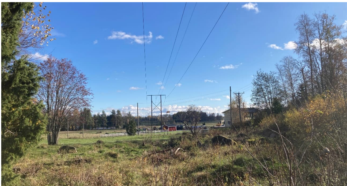
Figur 9. Foto som visar en av de trånga passagerna längs OL8. Den nya ledningen behöver sambyggas med befintliga ledningen på denna sträcka.
