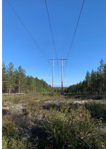
Figur 7. En träsäker ledningsgata inom regionnätet (Bild från Ellevio).
