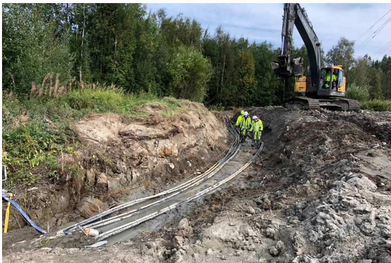
Figur 4. Fotot ovan visar arbetsområdet vid förläggning av en 30 kV ledning med tre kabelförband. (Bild från Skellefteå Kraft Elnät)
