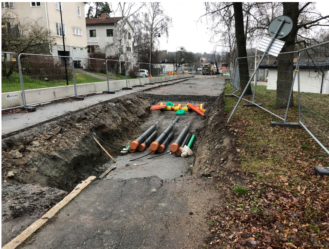
Figur 5. Kabelförläggning med tre kabelförband i Stockholm (bild från Energiföretagen).
