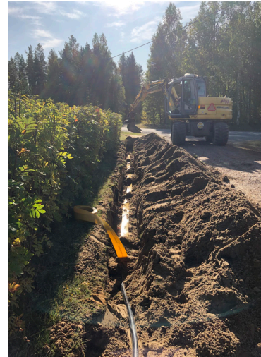
Figur 8. Kabelförläggning av en lokalnätsledning (Bild av Skellefteå Kraft Elnät).
