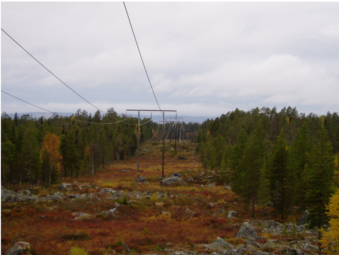
Figur 3. Fotot ovan visar skogsgatan för en 130 kV ledning (bild från Vattenfall Eldistribution).
