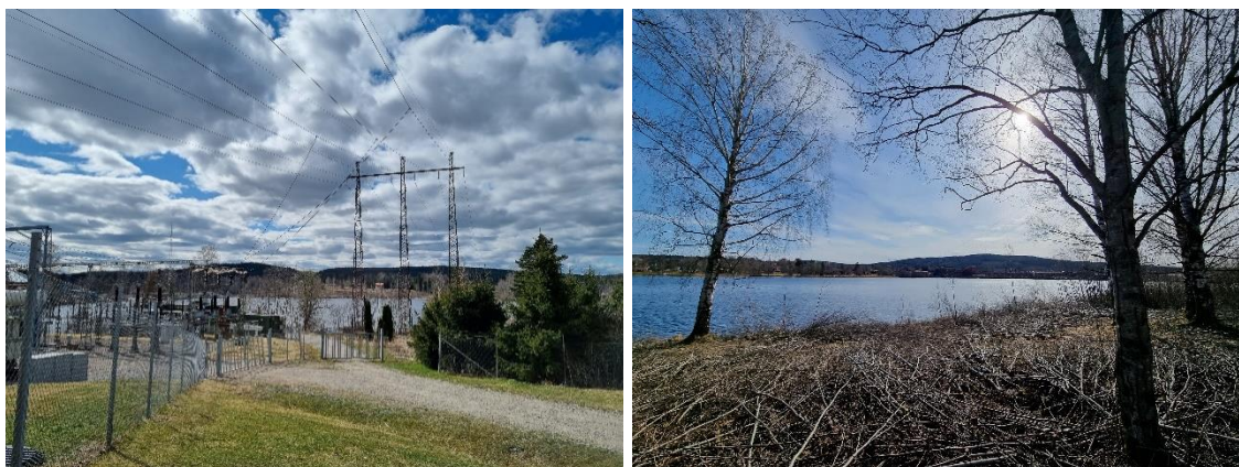
Figur 7. Hagfors ställverk och sjön Värmullen. I det vänstra fotot syns befintlig kraftledningsstolpe vid strandkanten och luftledningsspannet över sjön Värmullen skymtas. Foto: Rejlers Sverige AB.
