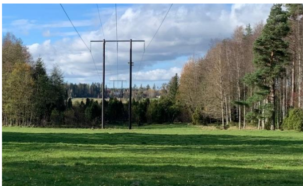
Figur 3. Figur till vänster visar ett exempel på hur utformning av luftledning med träportalstolpar kan se ut. Figur till höger visar en skiss över konstruktion av träportalstolpe
