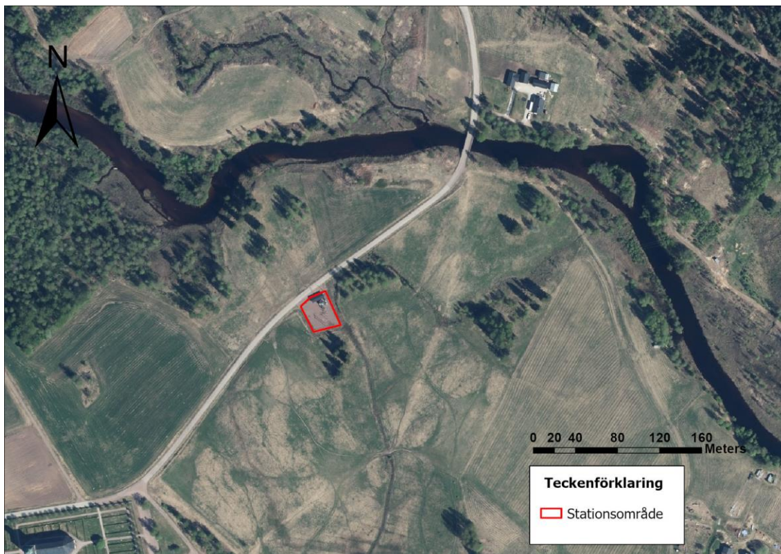
Figur 4. Befintlig station Våmhus.
