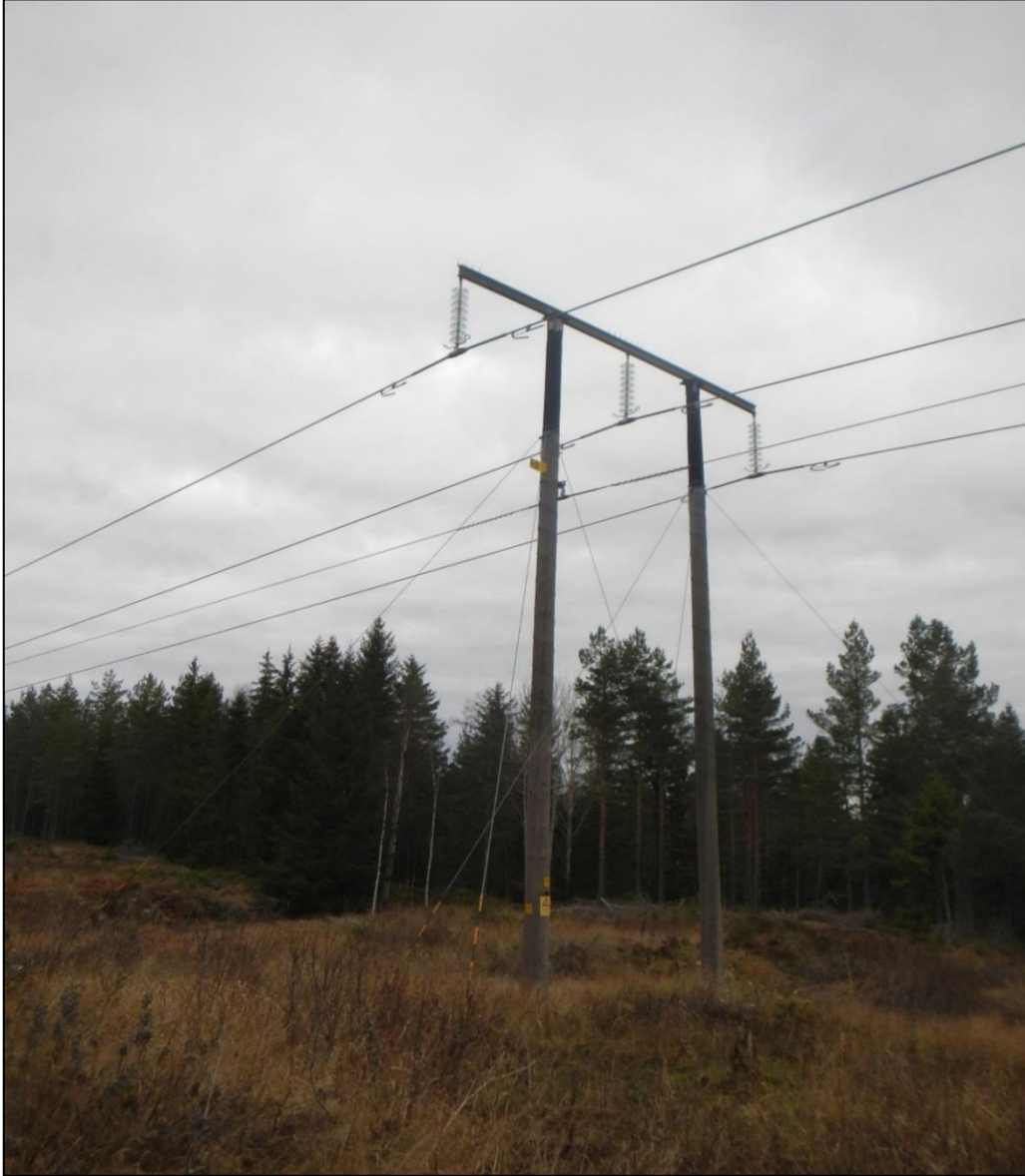
Figur 2. Aktuell ledning utförd i portalträstolpar.
