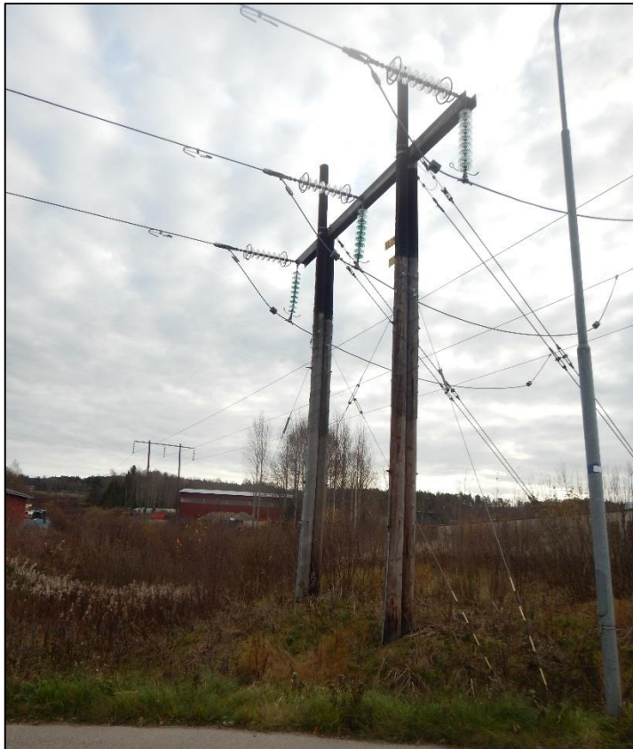
Figur 4. Påstickningspunkt för aktuell ledning på ledning VL25.
